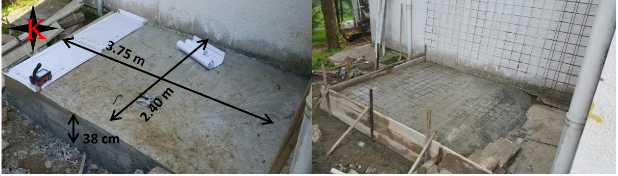
Şekil 11. Yer radarı araştırmasının yapıldığı çelik hasırlı beton yapı ve yer radarı ölçülerinin alınması
